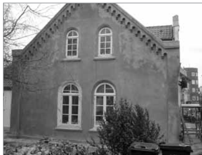
Facade efter færdigbehandling
