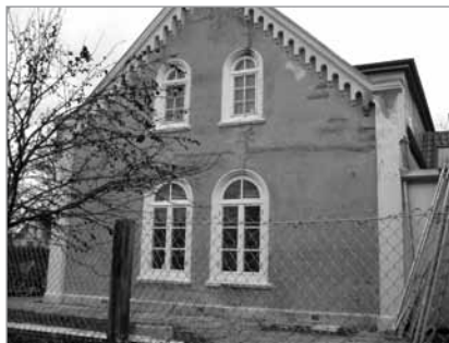
Facade efter rep. af revner med indlagt rustfrit tintorstål
