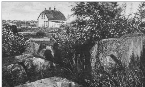
De fritgravede rester af krudtmagasinerne og blokhusfundamentet i Skanse X.
